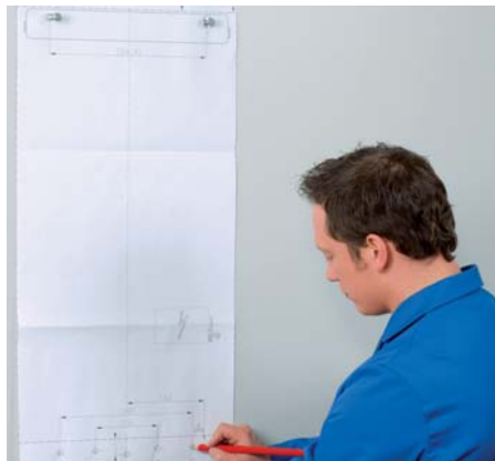
1. Příprava montáže pomocí montážní šablony
